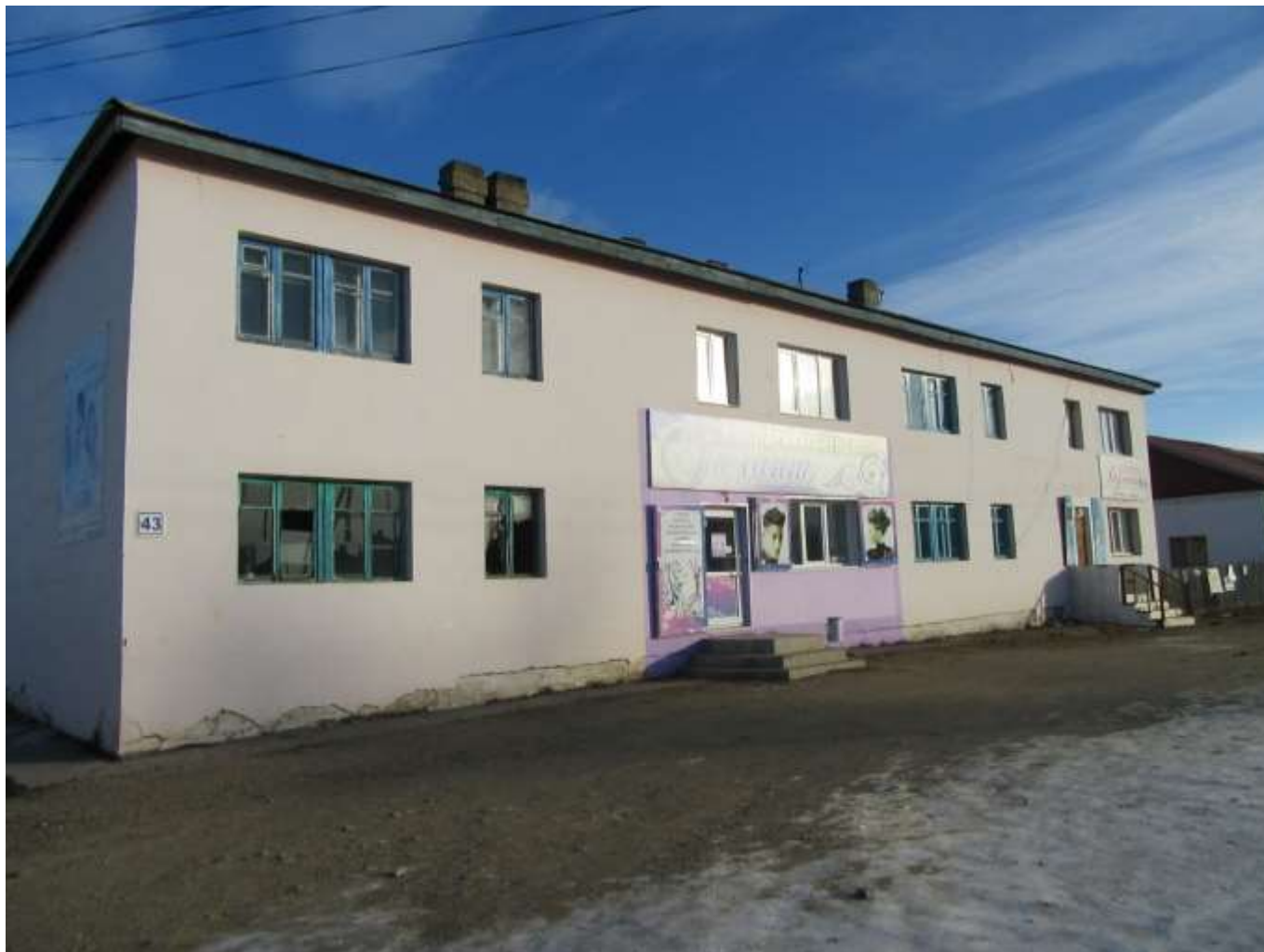
Фото 1. Общий вид обследуемого здания
